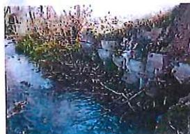
loses Bruchmauerwerk als Böschungssicherung
