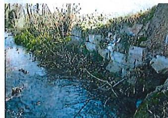
loses Bruchmauerwerk als Böschungssicherung
