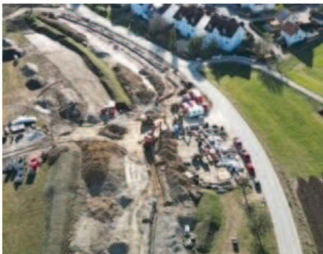
Auf den Bildern ist unter anderem der 3-fache Stufen-graben erkennbar, welcher momentan erstellt und bearbeitet wird. Dieser ist zum Beispiel für die Verlegung von Wasser- und Druckleitungen nötig. Zudem schreitet auch der Kanalausbau immer weiter voran.
