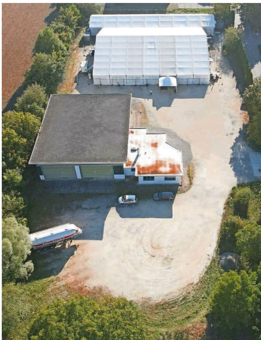
In dieser Unterkunft, welche durch das Landratsamt Konstanz errichtet wurde, sind die Geflüchteten untergebracht.
