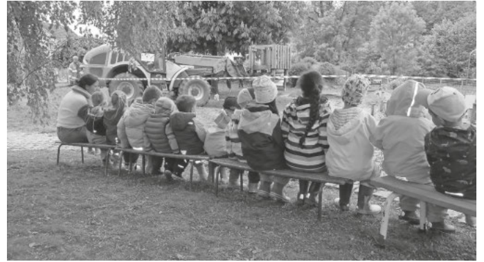
Abbau altes Klettergerüst
