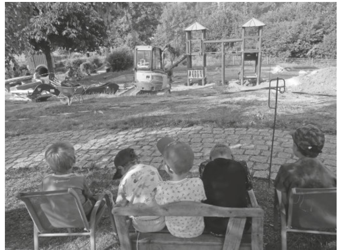
Aufbau neues Klettergerüst
